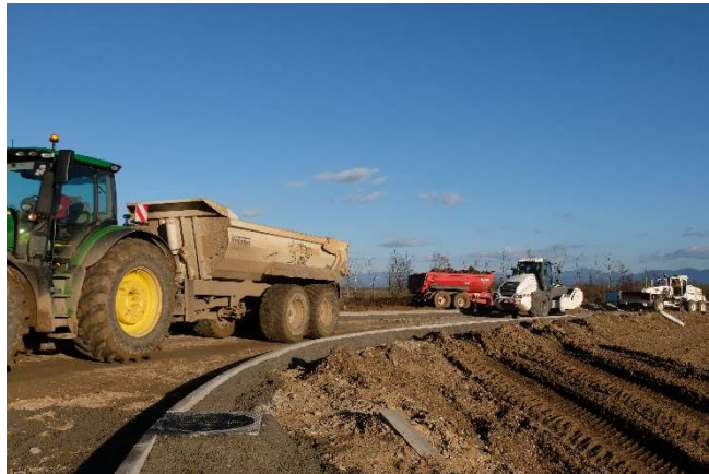
Voie d'insertion à l'autoroute, direction Mulhouse : préparatifs à la pose d'enrobés.
